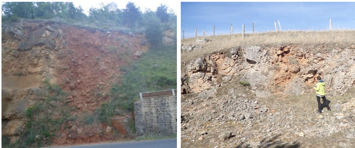
Figure 59 : Brèches d'altération et de tassement-effondrement contenues dans un couloir (à gauche) et brèches dans des poches karstiques de crypto-altération (à droite).
