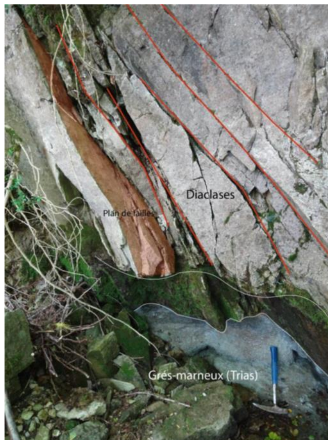
Figure 31 : Affleurement des dolomies hettangiennes affecté par des failles et des fractures. Voir localisation sur la figure 31 (photo C. Araïgno).
