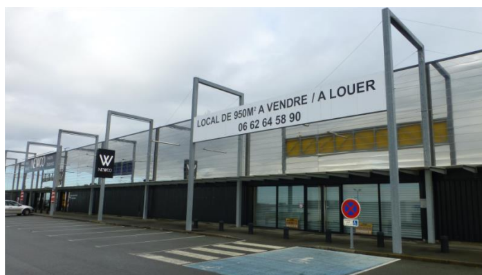
Figure 39 Vacance périphérique sur la zone Super U de Pouzauges
