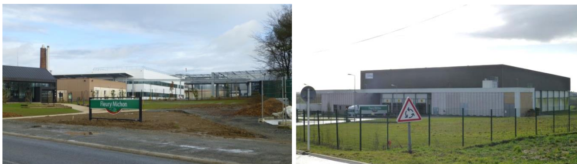
Figure 33 Fleury Michon site de Pouzauges gare et plate-forme logistique Sofrilog
