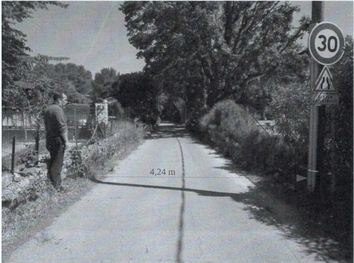
Profil 1 : mesure entre le muret et le poteau électrique
