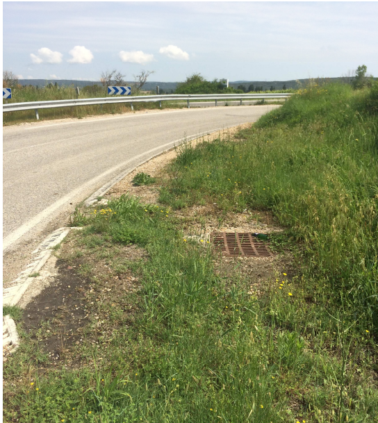
Figure 2 : Grille pluviale et passage busé sous la RD 192
