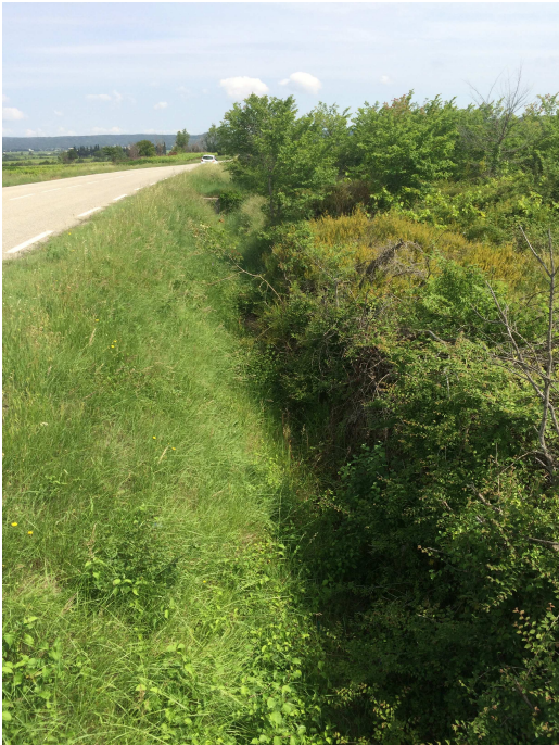
Figure 2 : Fossé le long de la RD 192 (côté Est)
