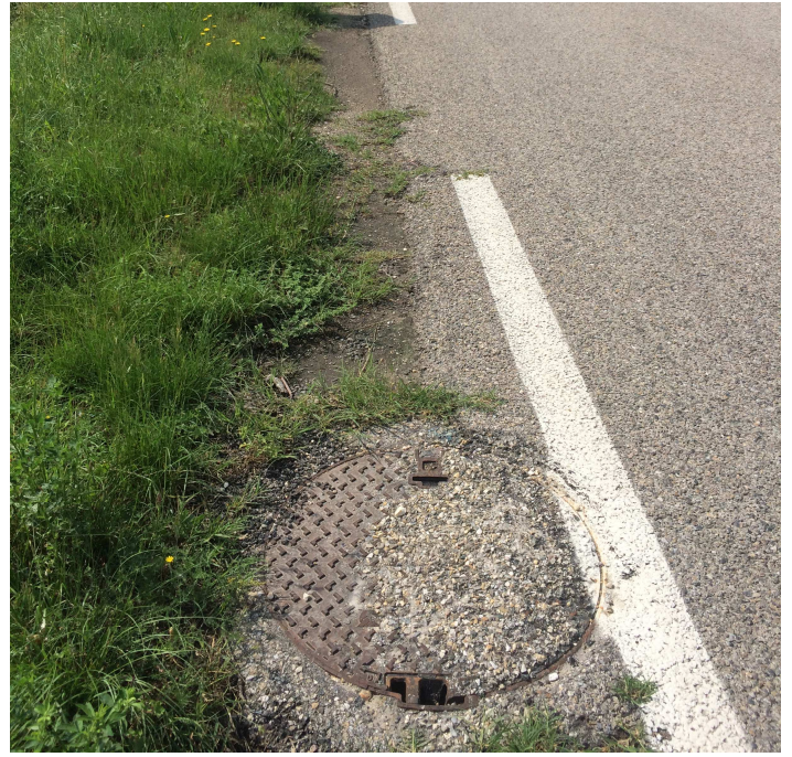
Figure 1 : Emergence en accotement Est de la RD 192
