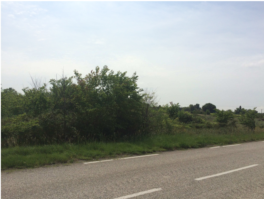
Figure 3 : Revêtement existant de la Rd 192
