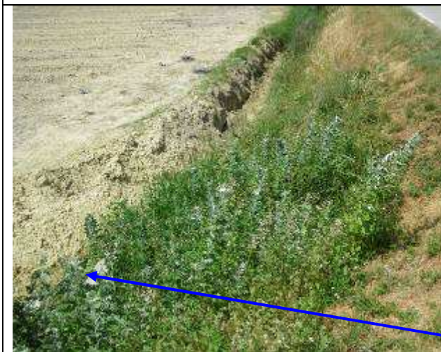
Photo 3 : Buse de traversée de la RD 192
