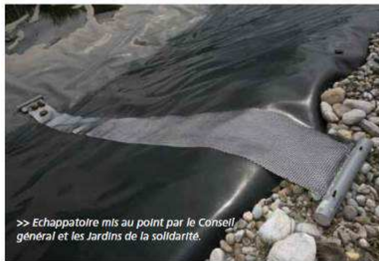
Exemple d'échappatoire évitant de piéger la petite faune (source : « Neutraliser les pièges mortels pour la faune sauvage »)
