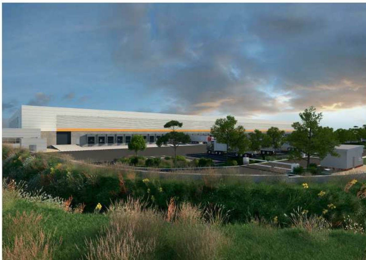
Figure 66 - Vue du bâtiment du Nord-Est vers le Sud-Ouest
