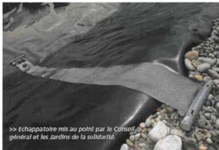
Figure 13 : Exemple d'échappatoire évitant de piéger la petite faune (source : « Neutraliser les pièges mortels pour la faune sauvage »)
