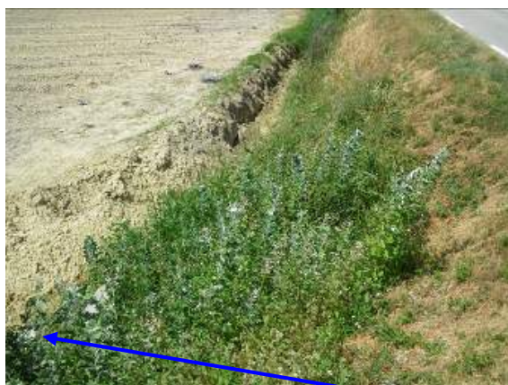
Photo 3 : Buse de traversée de la RD 192
