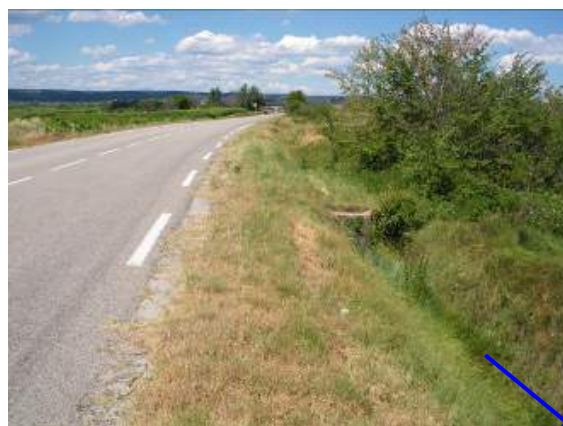
Photo 2 : Fossé pluvial de la RD 192
