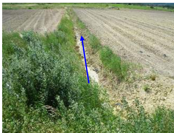
Photo 4 : Fossé pluvial à l'Ouest de la RD 192 (Exutoire des eaux pluviales de la zone d'étude)
