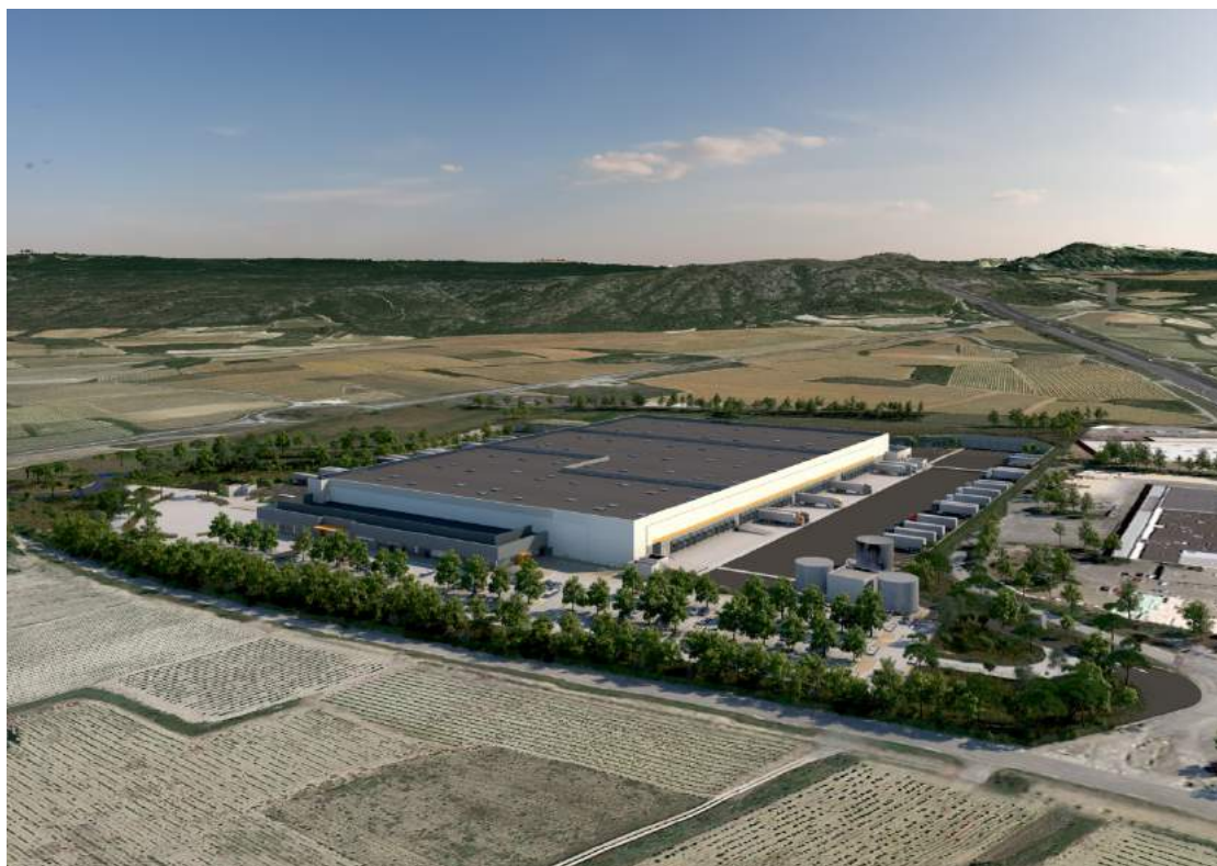
Vue aérienne du projet du Sud-Ouest vers le Nord Est.
