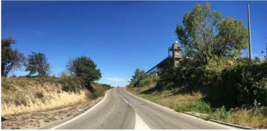
PC7-1 Vue du site depuis la RD 192 au Sud vers le Nord
