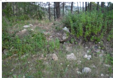
Déblais de chantier
