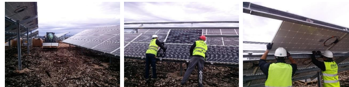
Exemple de montage des modules
