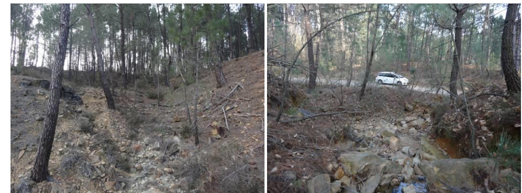
Photo 2 : Photos caractéristiques des zones d'accès et de travaux dans les secteurs boisés.
