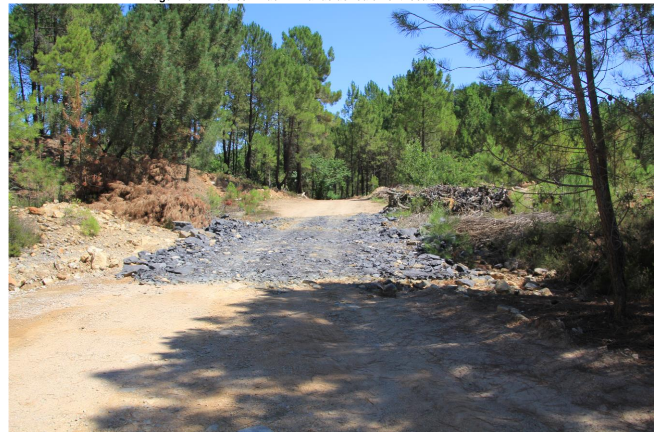
Page 127 - Photo 66 – Vue G – Piste sur le carreau d'exploitation sud
