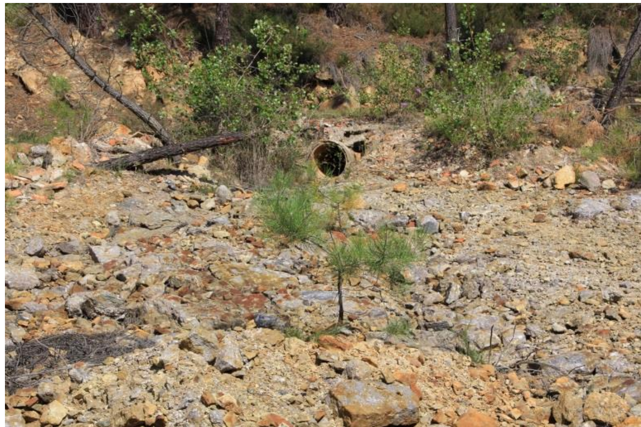
Page 75 Photo 43 – Buse rejetant les eaux de la route sur le 1 er carreau d'exploitation
