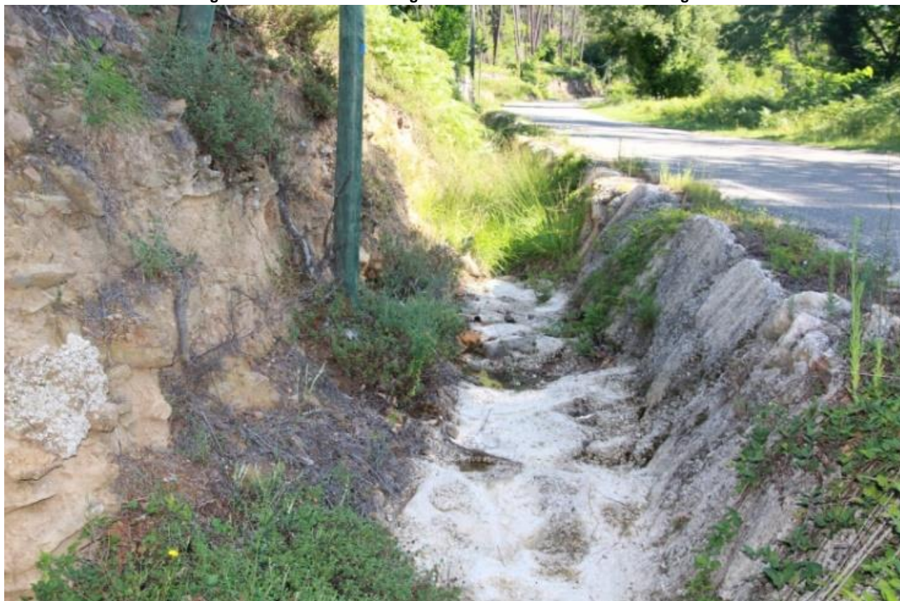
Page 73 Photo 33 – Fossé bétonné le long de la RD 217
