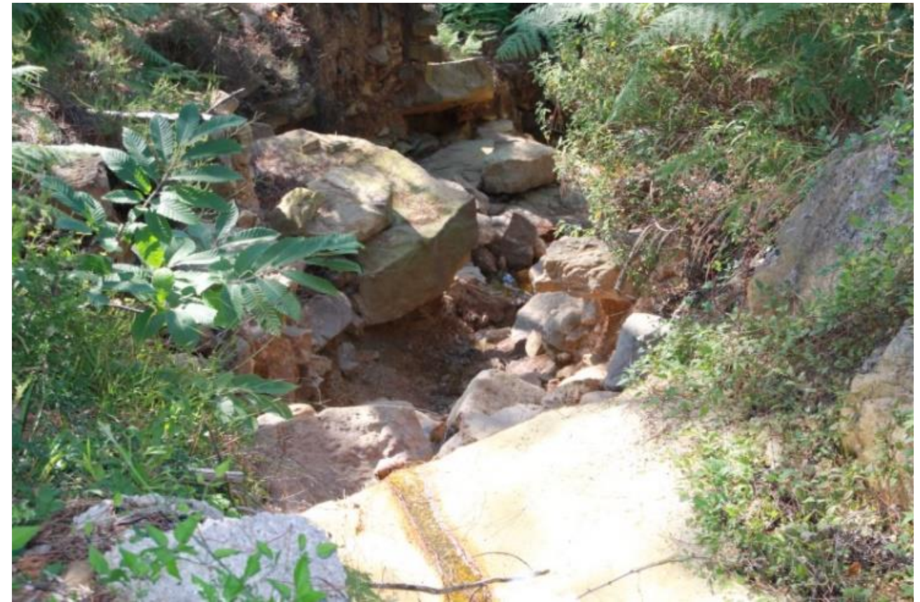
Page 73 Photo 34 – Sortie d'un passage busé sous la RD 217
