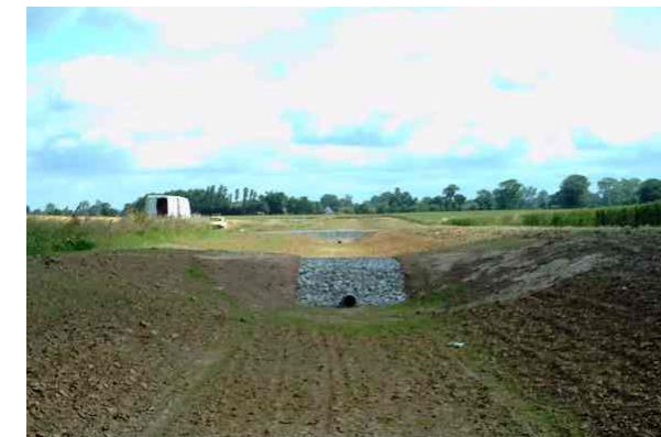
Illustration d'un seuil déversoir
