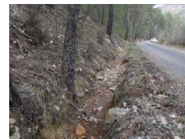
Débris végétaux et terre végétale naturellement charriée dans les fossés
