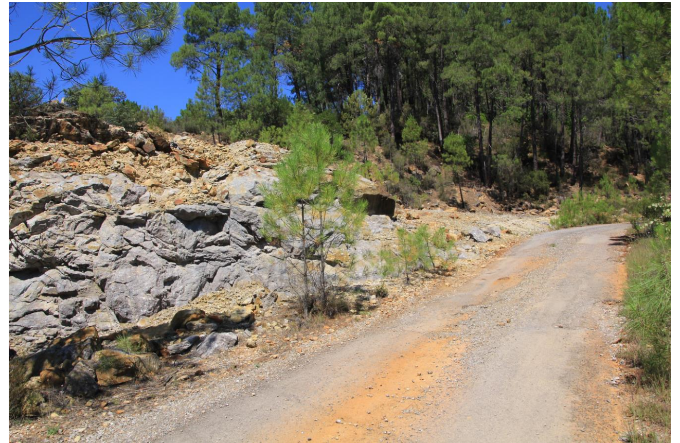
Page 126 - Photo 65 – Vue F – Bande de roulement localement détériorée
