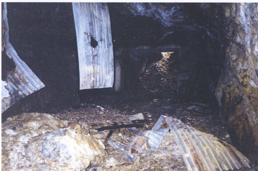
V 1 : entrée du 925 vue par l'intérieur : présence de blocs de caisse filonienne
