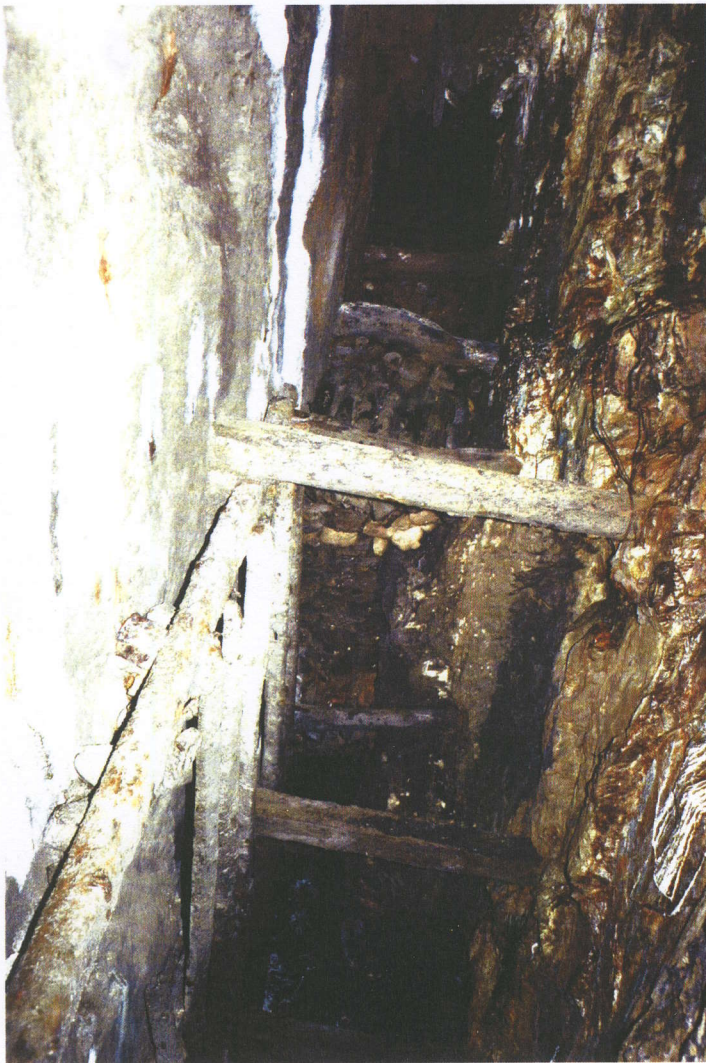
Cheminée au toit du 925 donnant dans grande chambre vide
