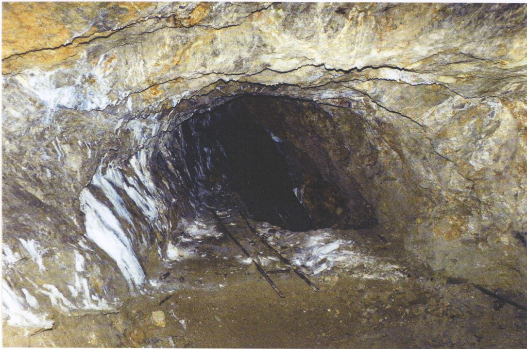
Chambre défilée et remblayée entre le niveau 1000 et le niveau 965 (On est en haut de la chambre, sur les remblais qui ont flué en contrebas)
