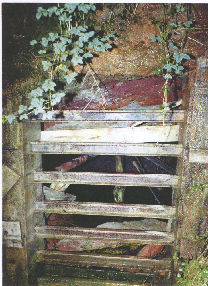
Entrée barreaudée de TB 843 V 14
