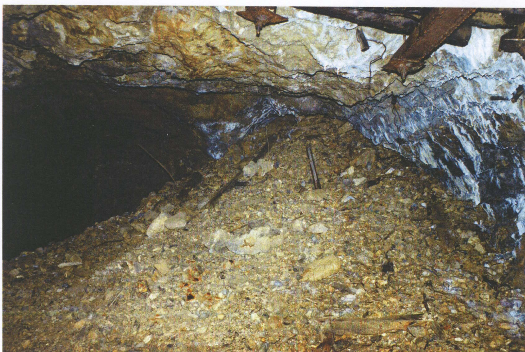
Tas de remblais au pied de la cheminée V 9
