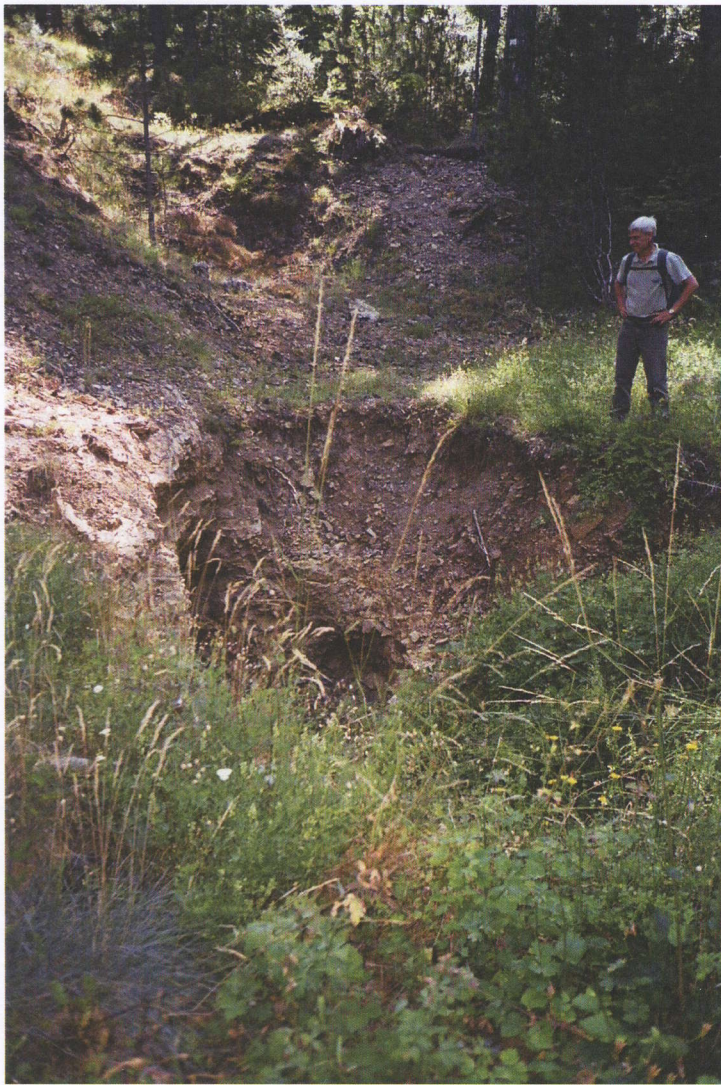
Cheminée V 9 après débourrage en Juillet 2004
