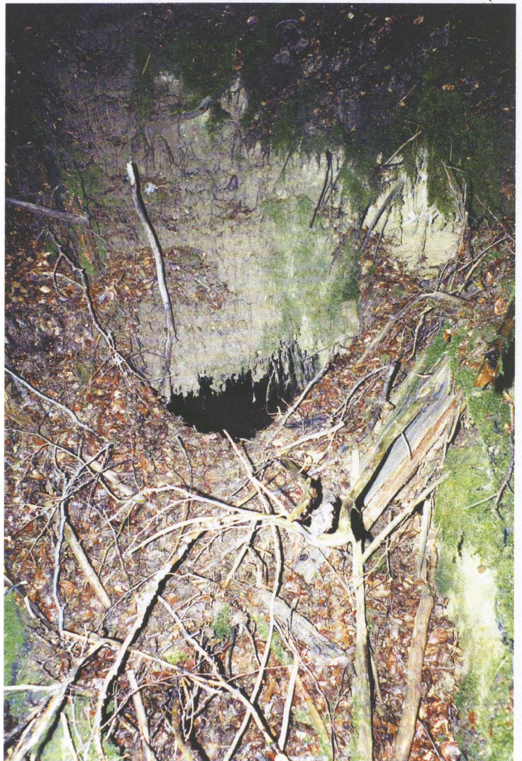
Galerie de la Mine de la Boissière, partiellement dissimulée par une accumulation de feuilles mortes, de terre et de branchages
