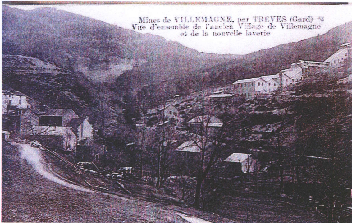
Vue du village et de la laverie de Villemagne
