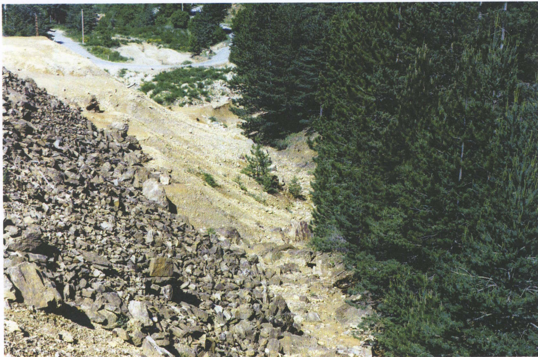
Vue du Chenal entre le flanc Nord du Vallon et la digue haute
