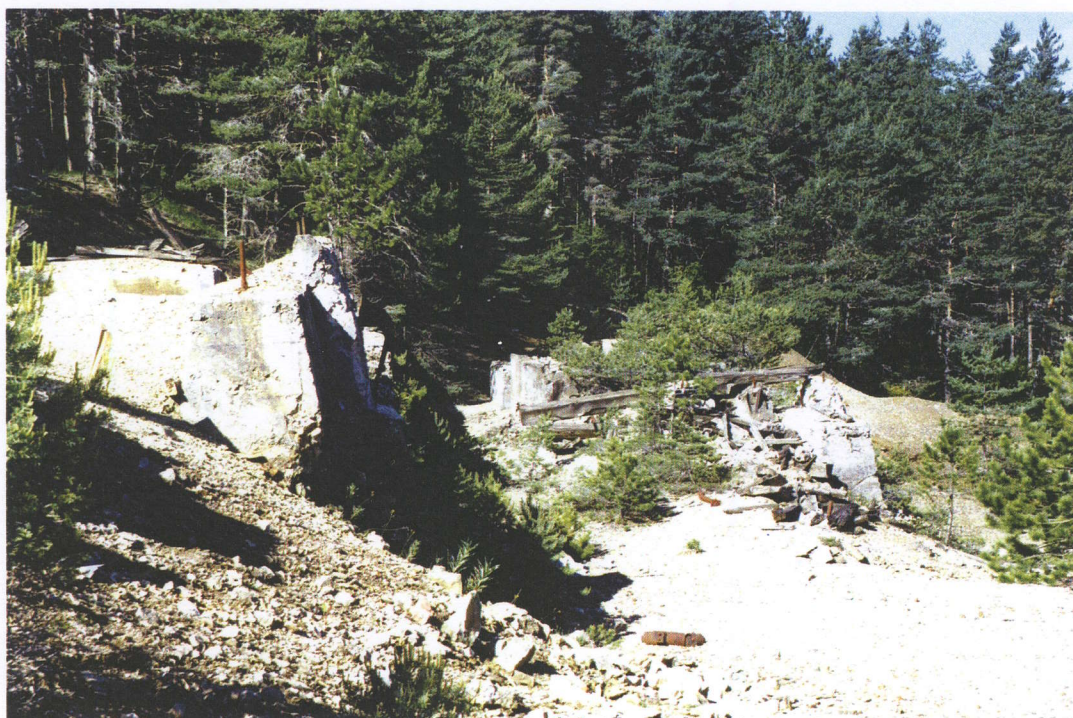
Ancienne laverie : partie basse avec les massifs à démolir
