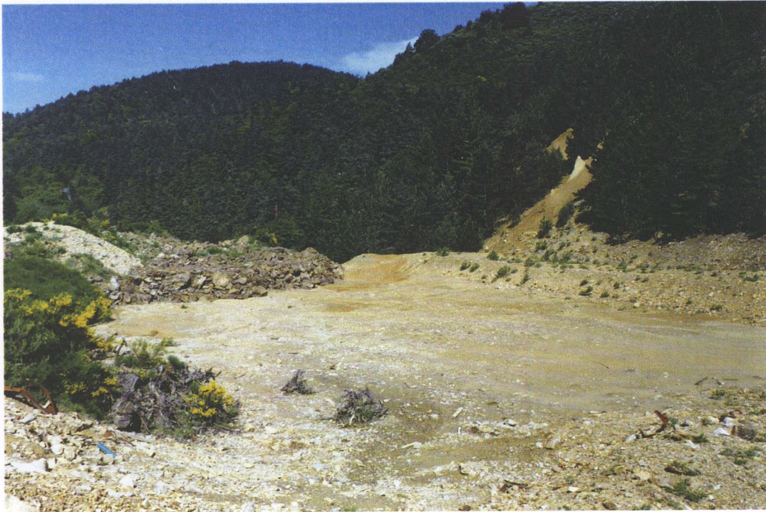
Terminaison Est de la digue haute
