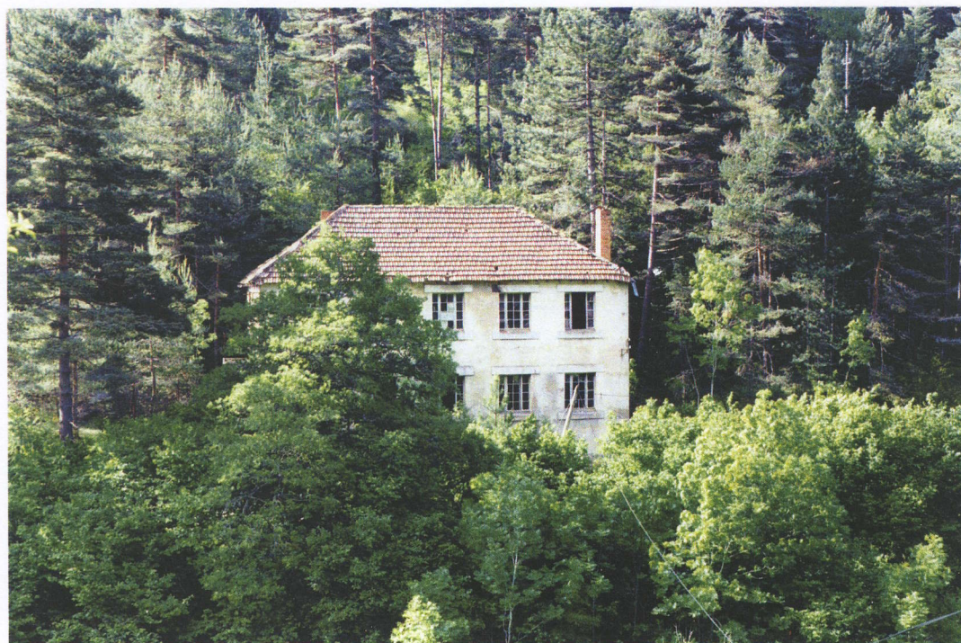
Aspect du bâtiment des bureaux en 2000
