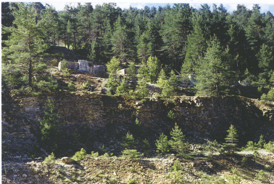
Ancienne laverie : plate formes partiellement reconquises par la forêt. Massifs à démolir
