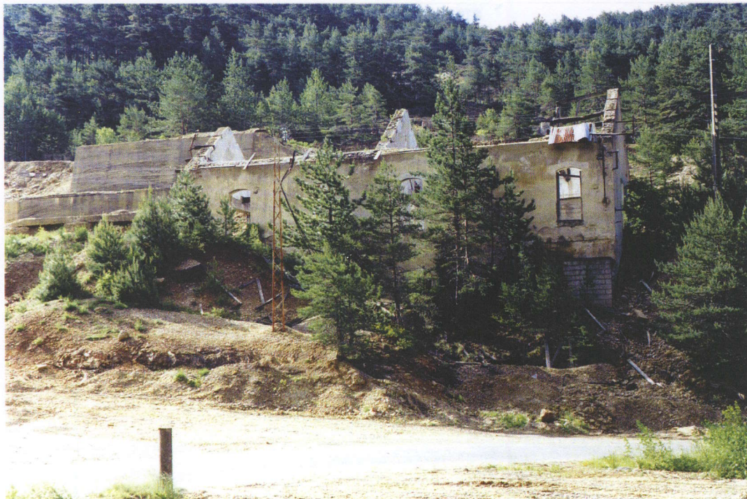
Aspect du bâtiment ruiné du carreau de la mine en 2000
