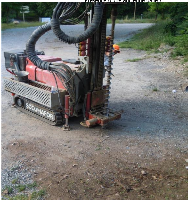
Photographie de la tarière mécanique au droit du sondage T16
