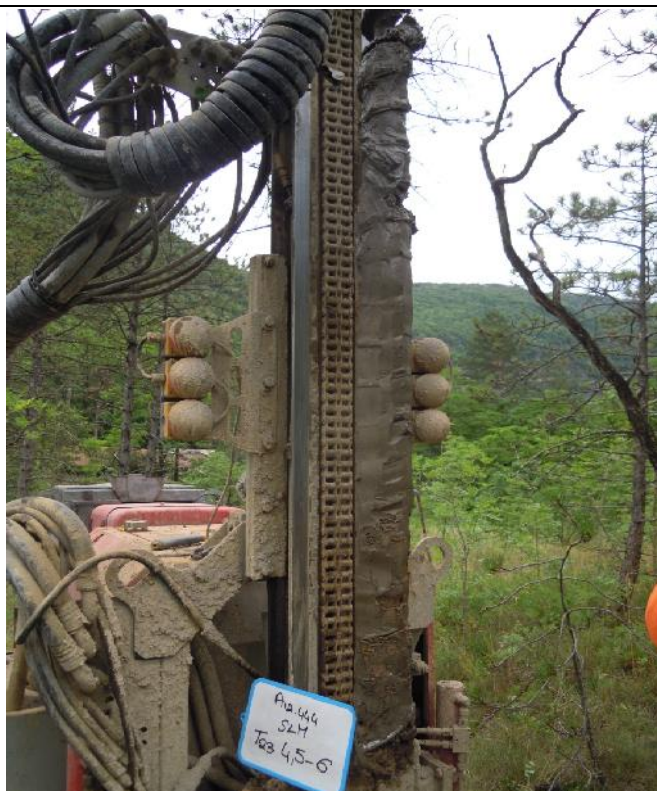
Photographie des sols compris entre 4,50 et 6,00 m de profondeur
