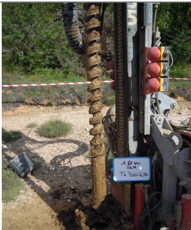
Photographie des sols compris entre 3,00 et 4,50 m de profondeur
