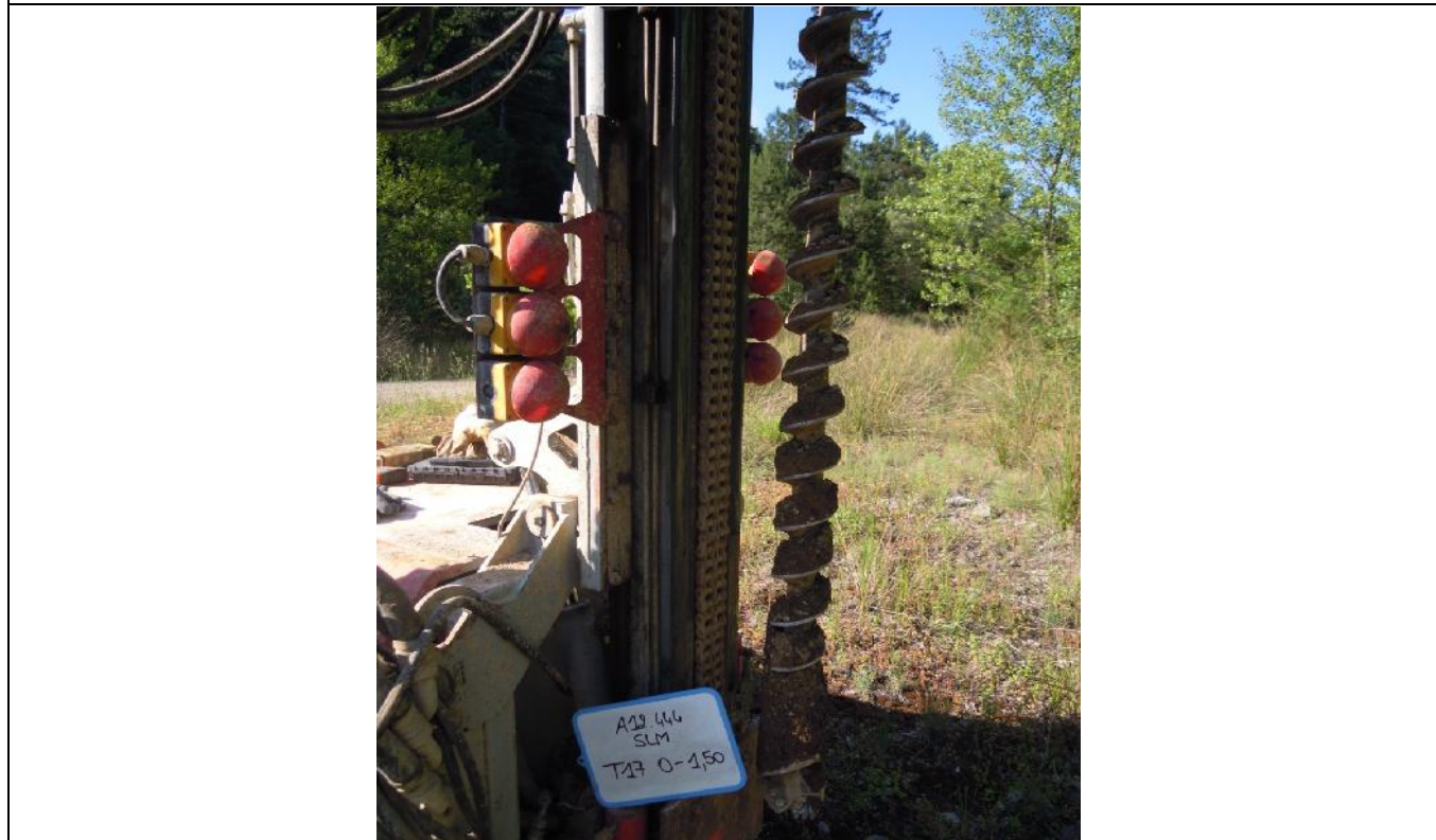
Photographie des sols compris entre 0 et 1,50 m de profondeur
