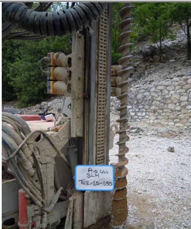
Photographie des sols compris entre 1,50 et 1,95 m de profondeur
