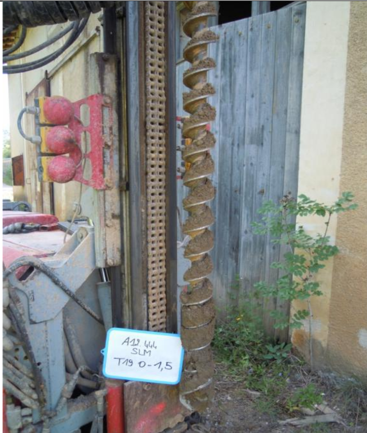
Photographie des sols compris entre 0 et 1,50 m de profondeur
