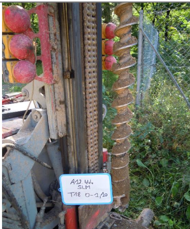
Photographie des sols compris entre 0 et 1,10 m de profondeur
