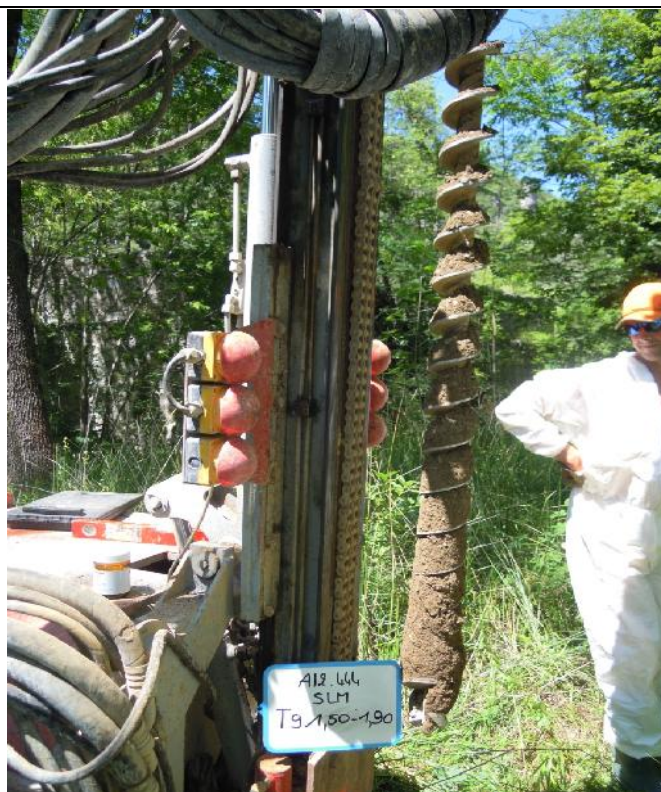
Photographie des sols compris entre 1,50 et 1,90 m de profondeur
