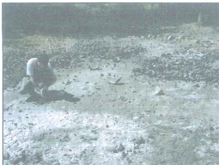
Photo 3 : Zone de dépôts de résidus de traitement identifiée au sud de la digue à résidus
