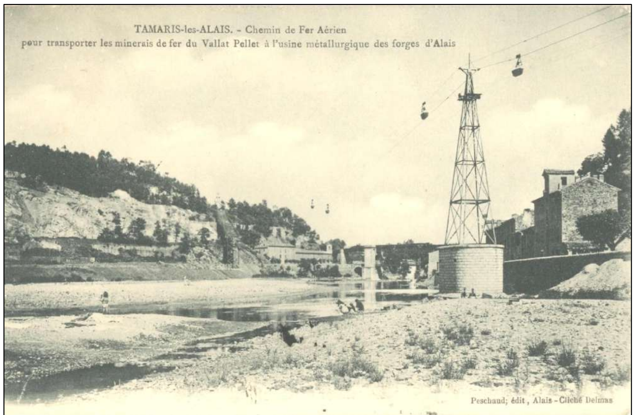
E- Alais – Photographie du câble aérien transportant le minerai de fer vers l’usine de Tamaris en passant par-dessus le Gardon
