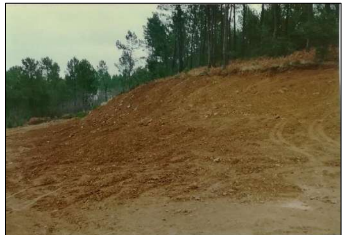
Photos de la carrière avant et après les travaux de 1989 (remblaiement du front de taille avec les matériaux d'origine)
