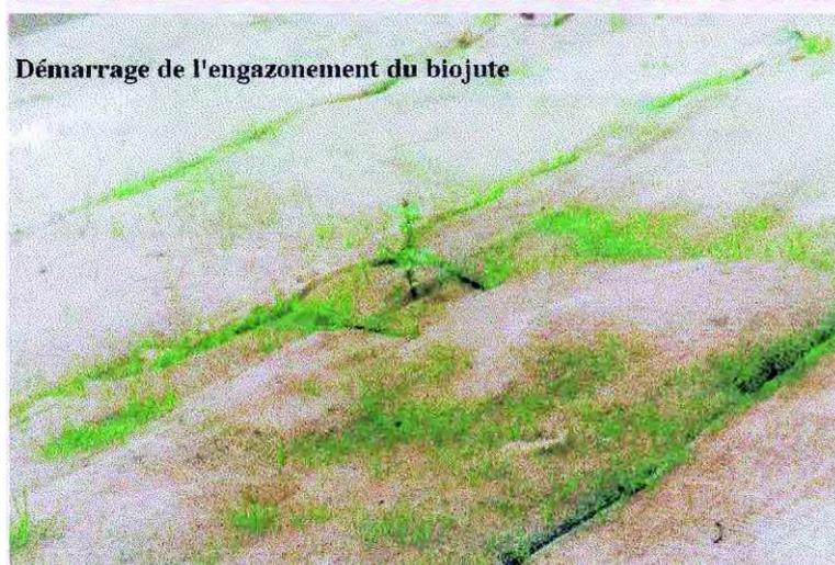
Pose du biojute sur les talus de la digue
