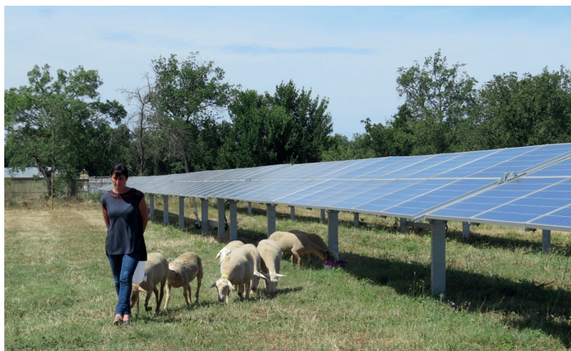
Parc photovoltaïque Arkolia Énergies Le Soler
