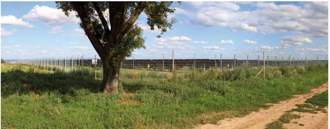
Installation photovoltaïque au sol
