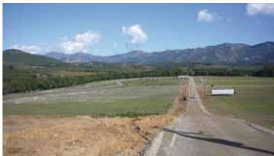
Route et chantier
