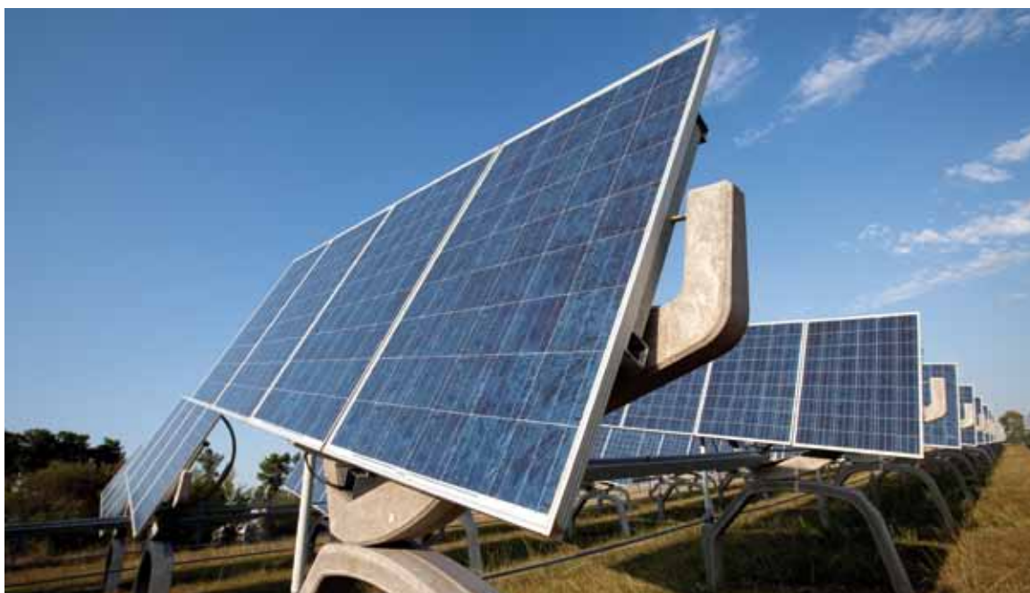
Installation photovoltaïque équipée de suiveurs
