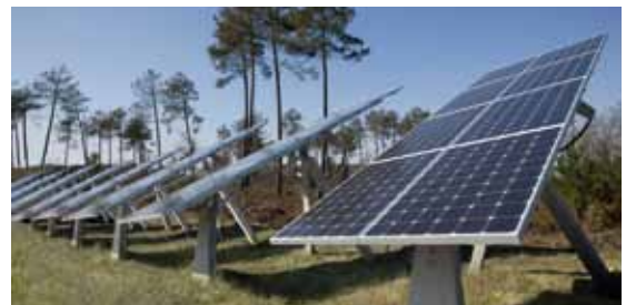
Suiveurs à rotation mono-axiale
