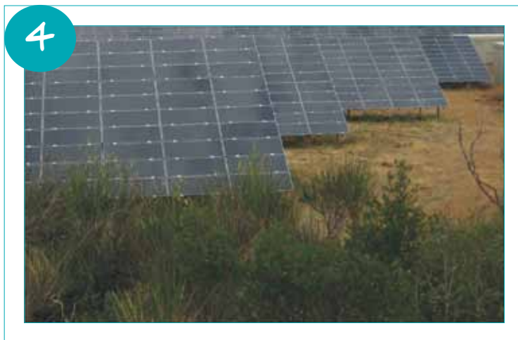
Récupération du modèle de panneaux photovoltaïques
