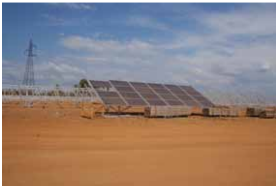
Pose des modules sur les supports
