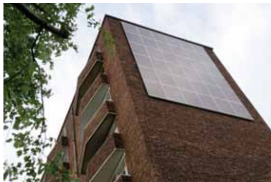
Installations solaires sur des bâtiments
