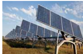
Suiveurs à rotation bi-axiale
