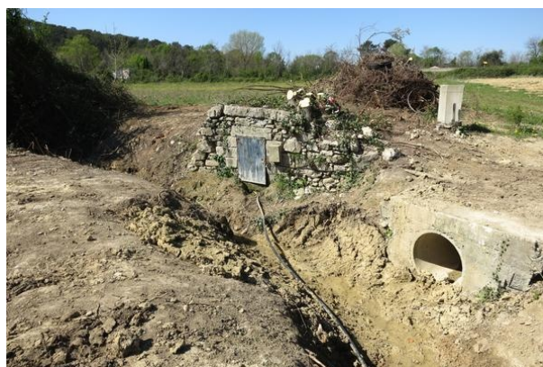
Photo 12: source après décapage 12/04/2015
