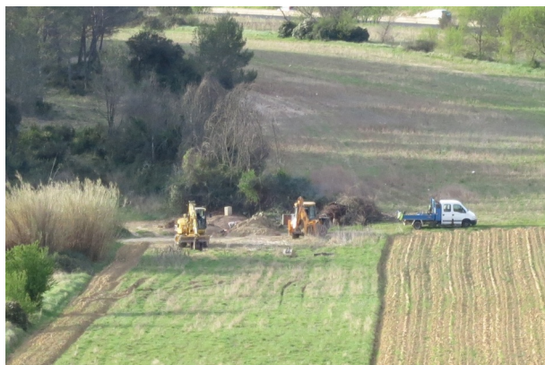
Photo 11: travaux sur la source 03/04/2015
