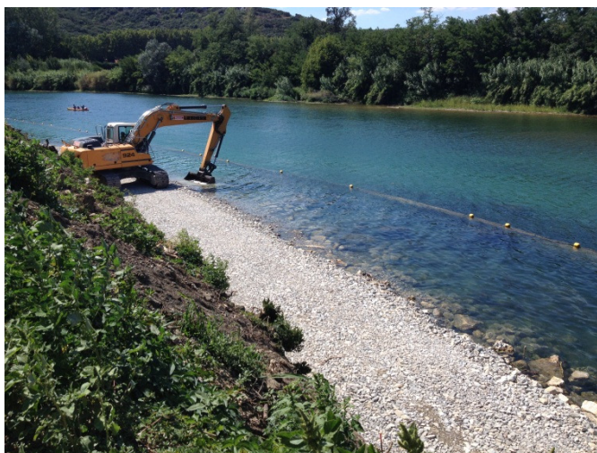
Préparation de l'assise des gabions
