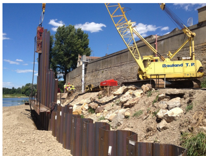
Rideau de palplanches en cours de mise en place
