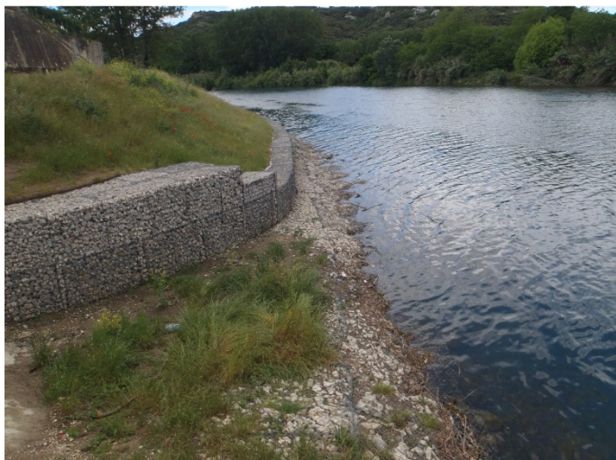
Travaux achevés – vue amont
