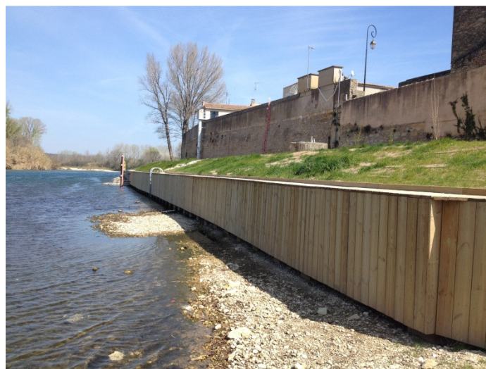
Travaux achevés – vue sur l'habillage bois des palplanches et la digue
