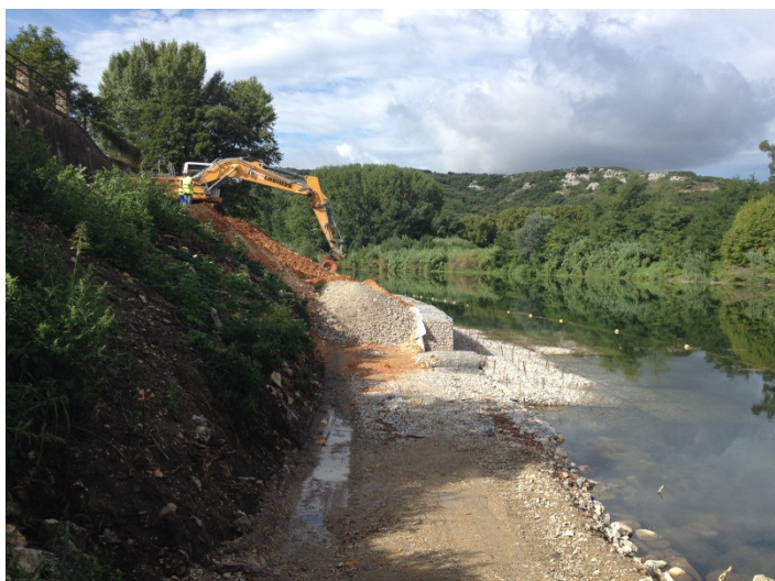
Remblaiement de la berge en cours
