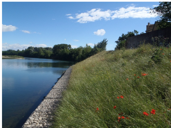
Travaux achevés – gabions et berge enherbée
