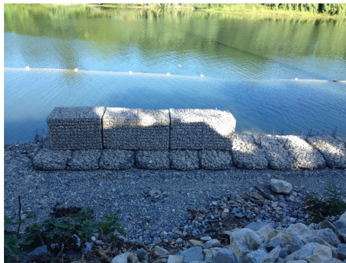
Premiers gabions posés sur le tapis de matelas Réno
