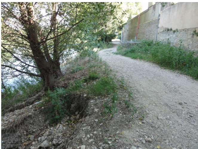
Etat de la berge avant travaux
