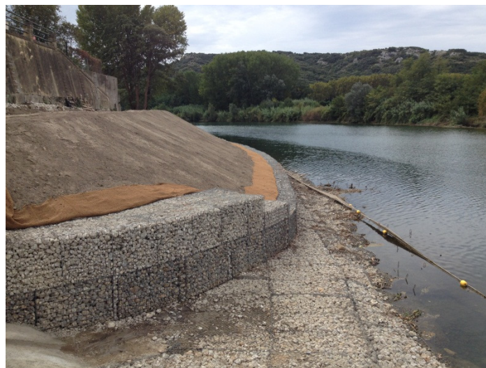
Mise en place de la terre végétale
