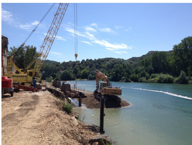
Battage des palplanches
