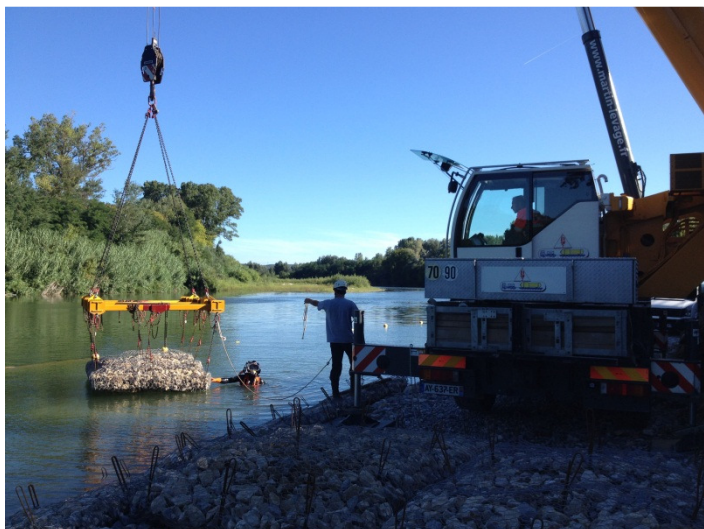
Pose subaquatique des matelas Réno
