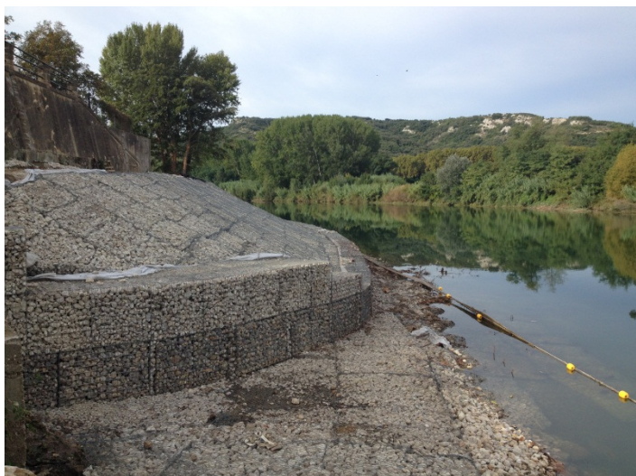
Protection en gabions et matelas Réno
