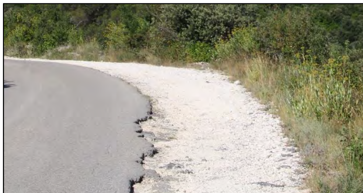
Photographie de matériaux calcaires mis en place sur le bas-côté de la route d'accès aux carrières de Moulézan pour augmenter sa largeur (source : ATDx)
