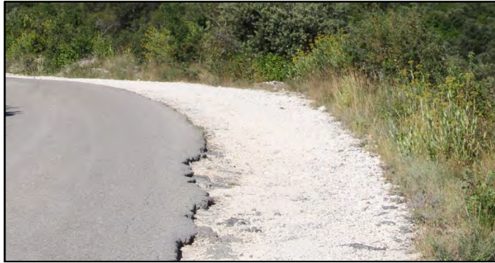
Photographie de matériaux calcaires mis en place sur le bas-côté de la route d'accès aux carrières de Moulézan pour augmenter sa largeur (source : ATDx)
