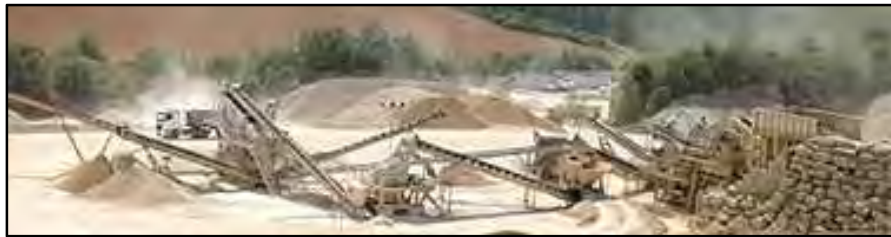
Exemple d'installations fixes de carrière
