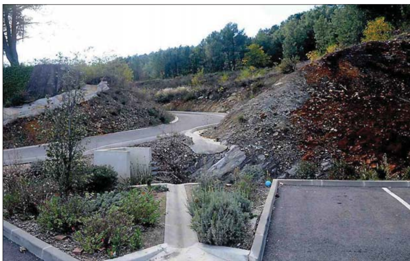
■ La gendarmerie a été construite sur une ancienne mine. Depuis 2009, la pollution est évoquée.
