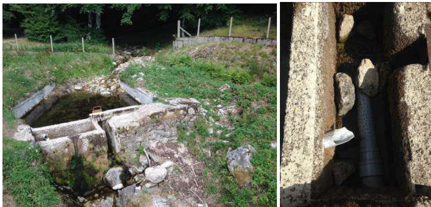
Figure 18 : Vues actuelles du captage du « Devois » (Source : CEREG Ingénierie)
