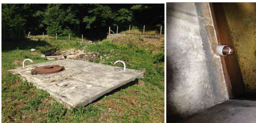
Figure 19 : Vues actuelles de l'ouvrage de décantation du « Devois » (Source : CEREG Ingénierie)
