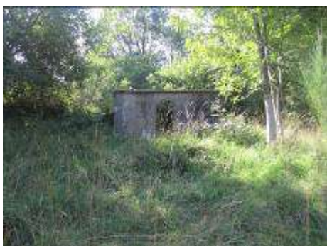
Réservoir des « Monts »
