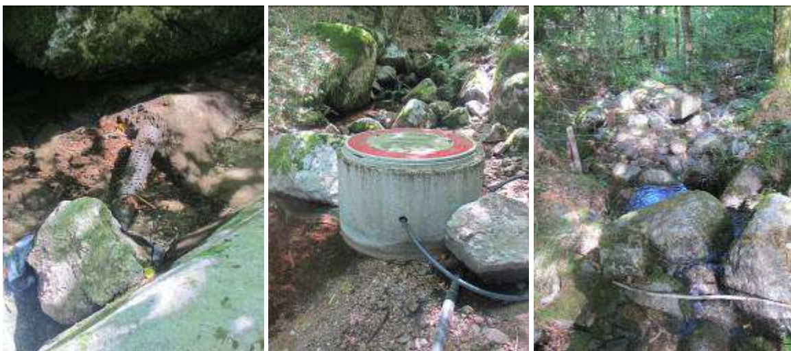
Figure 21 : Vues actuelles du captage de « Malbosc » (Source : CEREG Ingénierie)
