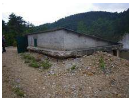
Réservoir de « Villemagne »
