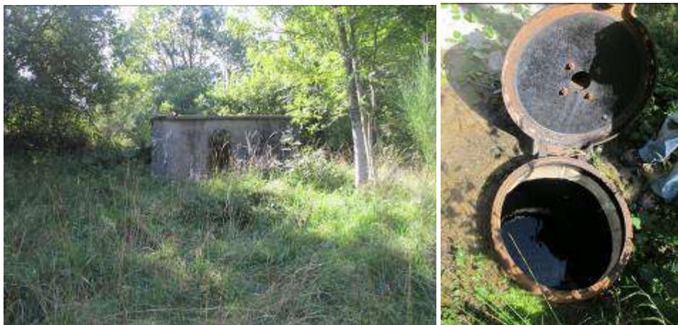
Figure 23 : Vues actuelles du captage des « Monts » (Source : CEREG Ingénierie)
