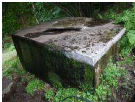
Réservoir de « Malbosc »
