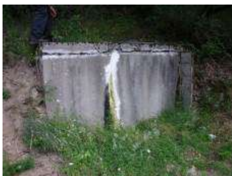
Réservoir de « Ribauriès »
