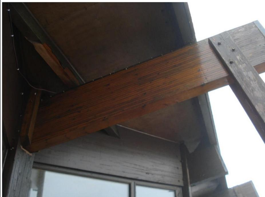
⇒ Des réparations / renforcement ont déjà été réalisés. Les arbalétriers dégradés sont à remplacer.
