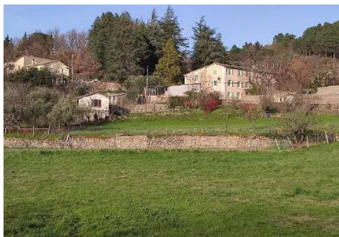
Muret en pierres en grande partie jointées faiblement favorable aux reptiles à enjeu
