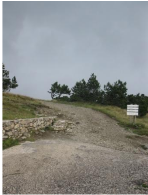
Mauvaise praticabilité des sols Absence d'aménagements PMR
