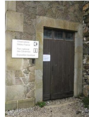
Accès à optimiser. Ici, accès à l'exposition
