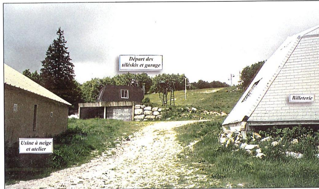
La billetterie et le local départ téléski (avec le garage) comportent des menuiseries en aluminium, alors que les murs sont revêtus de parpaings ou de bardaux d'asphalte noir.
