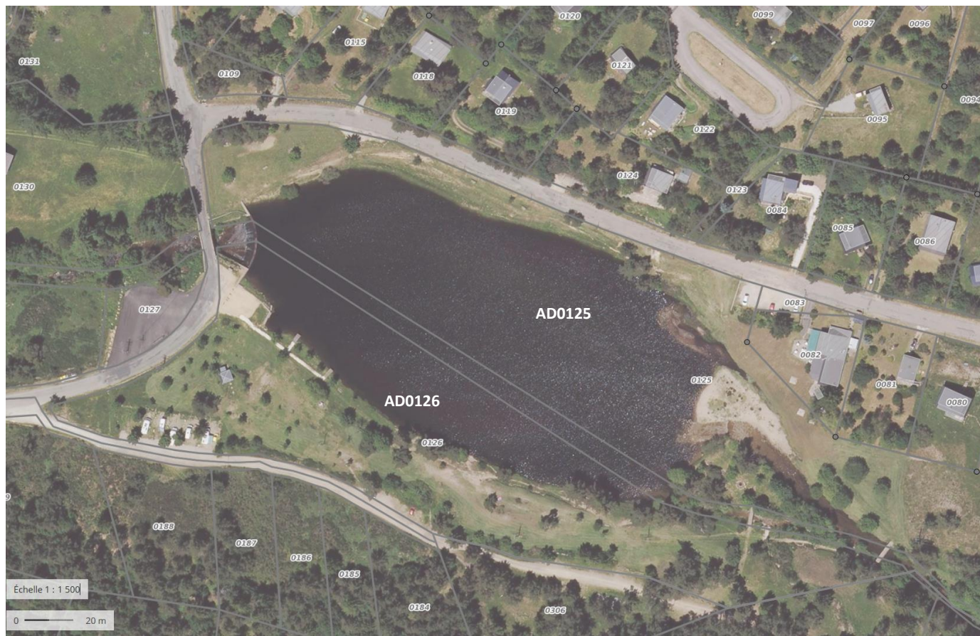
Illustration 2 : Extrait cadastral au droit de l'ouvrage
