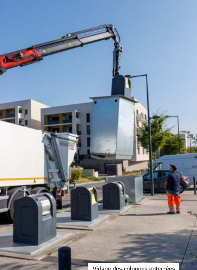
Vidage des colonnes enterrées
