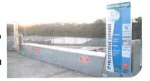
Les déchèteries de Liouc et de Saint Hippolyte ont été mises aux normes de sécurité en 2018/2019 avec la mise en place de garde-corps, sécurisation des quais, signalisation au sol, pose de panneaux de filière et de sécurité, barrière levante à l'entrée, vidéo surveillance, réfection des sols béton et bitumineux, renfort des clôtures...
