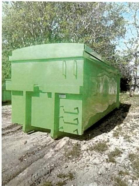
Le plâtre est collecté en benne capotée pour éviter que le plâtre ne soit humide
