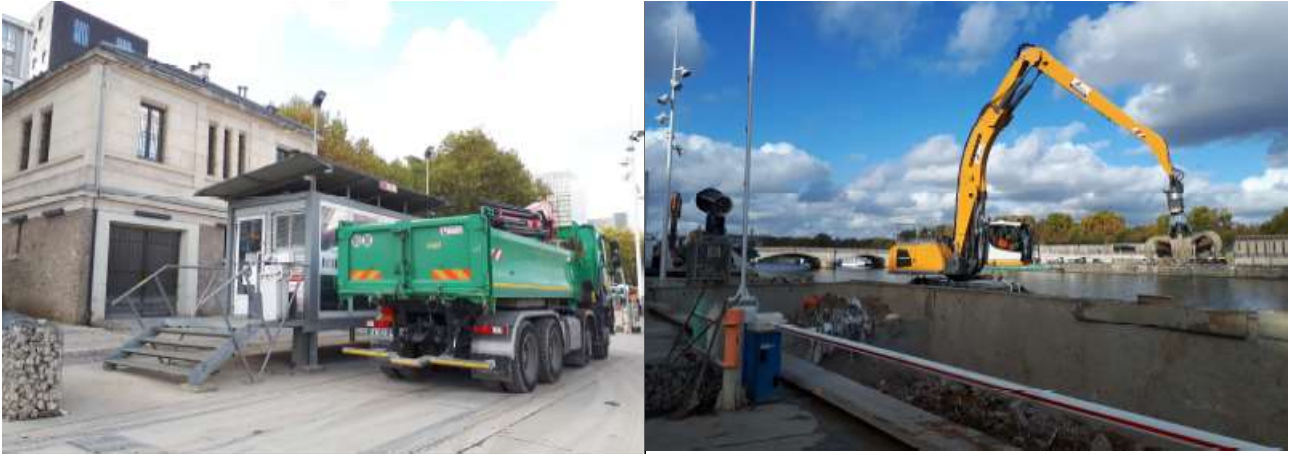
Photos de la plate-forme du quai de Bercy (Paris, 6 novembre 2019).
