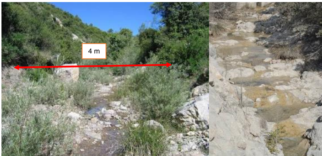
Figure 60 : Le valat du Carriol à l'amont et à l'aval de la carrière
