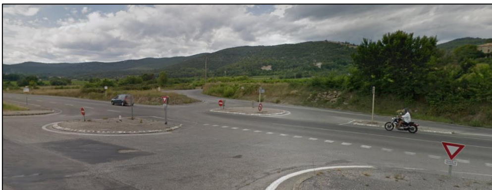
Photographie 8 : Aménagement du carrefour de la RD 910a
