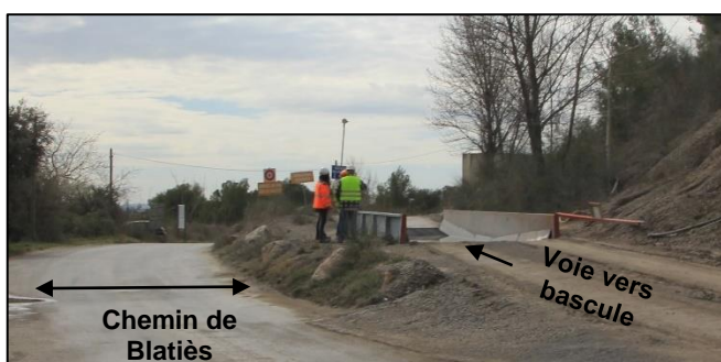
Photographie 9 : Chemin de Blatiès et accès à la bascule
