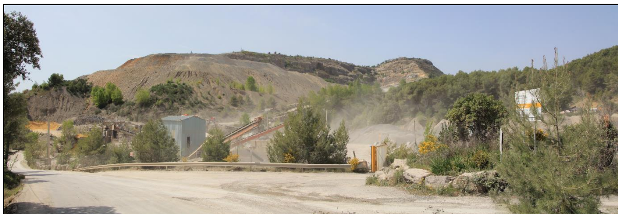
Photo 1 : Carrière de calcaire exploitée par GSM sur la commune de Bagard
