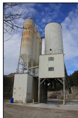
Photo 3 : centrale à béton UNIBETON
