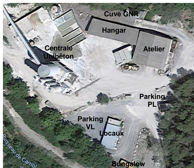
Figure 1 : Vue aérienne des installations annexes localisées dans le nord de la zone d'étude
