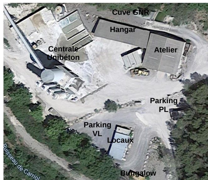
Figure 21 : Vue aérienne des installations annexes localisées dans le nord de la zone d'étude
