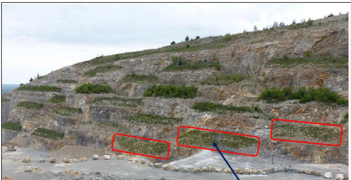
Photographie 5 : Vue sur les fronts déjà réaménagés à l'ouest
