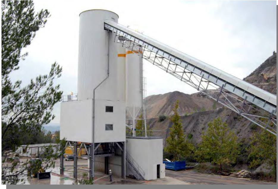
Centrale à béton sur la carrière calcaire de Bagard (photo: GSM granulats)
