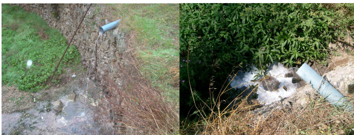
Prises de vues du rejet des eaux usées collectées sur l'Euzière
