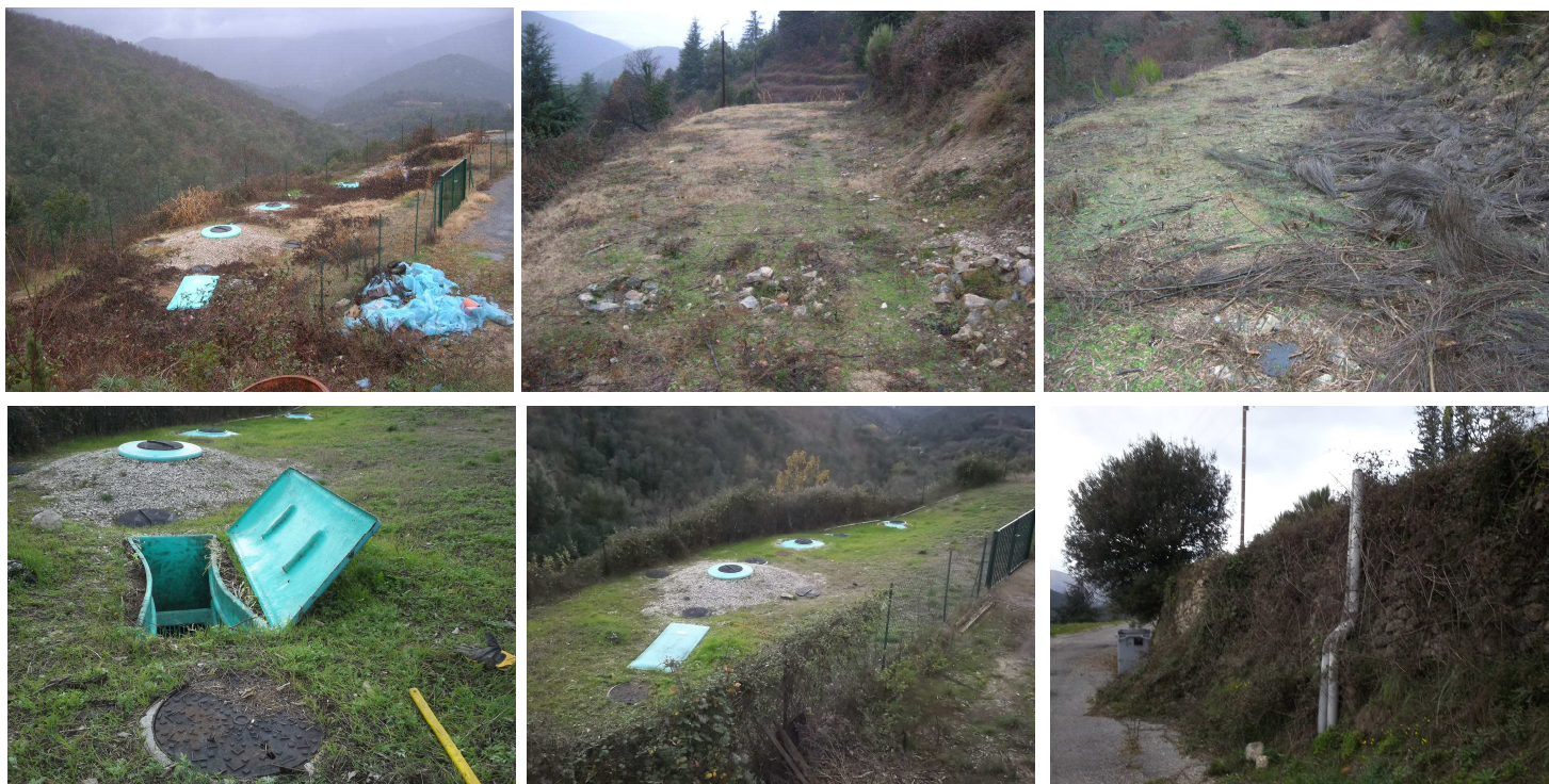
Prises de vue de la station d'épuration du village
