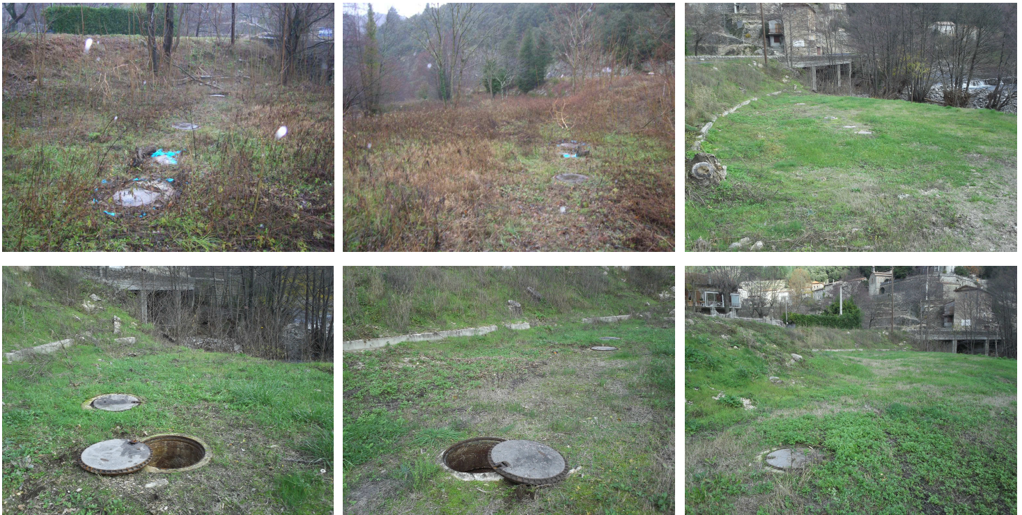
Prises de vue de la station d'épuration du Mazel
